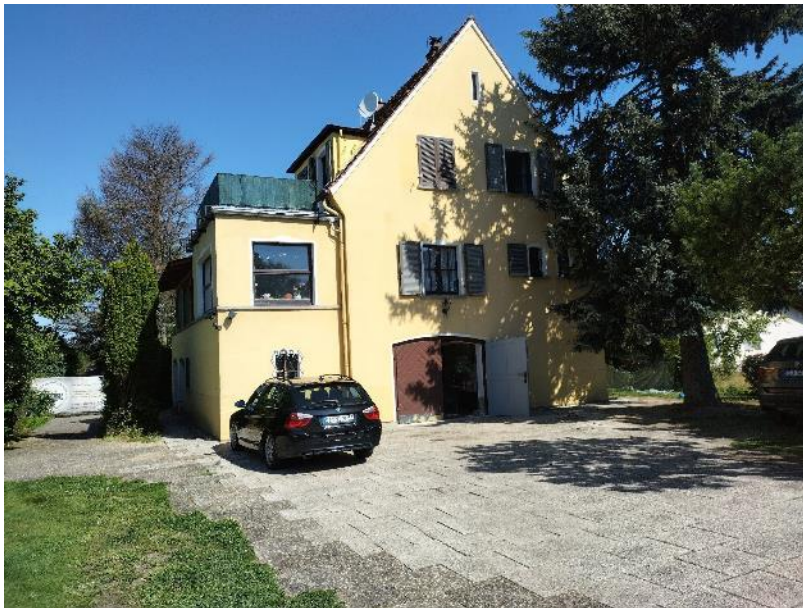
Abbildung 4 Übersicht abzubrechende Gebäude
