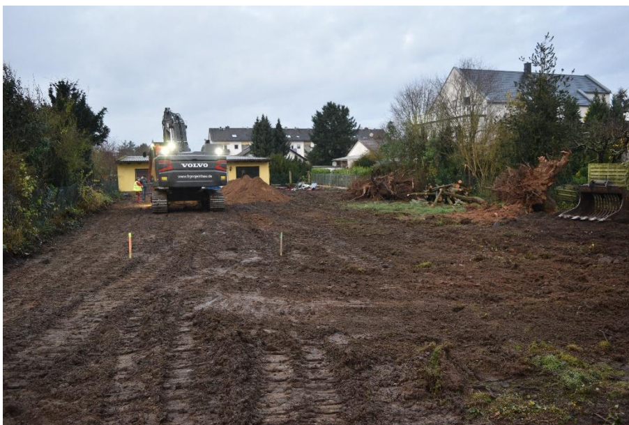
Abb. 01: Das zu bebauende Gelände mit bereits gerodeten Bäumen und entfernter Pflasterung während des Anlegens der Sondage. (Foto: S. Pohl)
